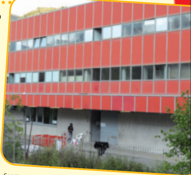
Sopra: Un centro di accoglienza temporaneo, ospitato presso una caserma in disuso dei Vigili del Fuoco.
